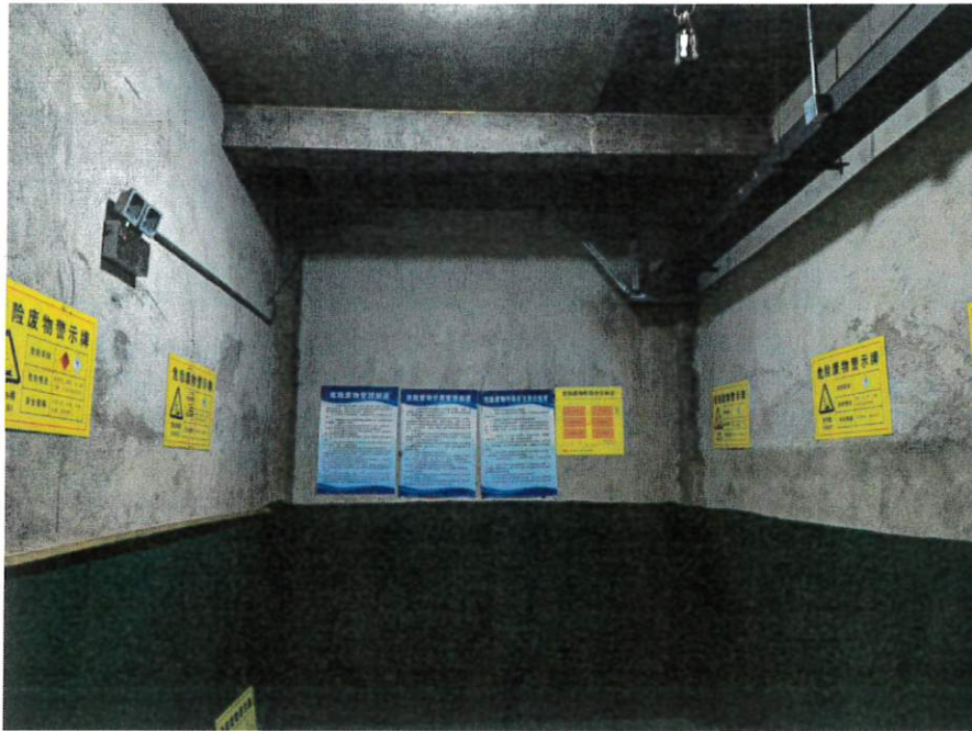
图 3.1-7 危险废物暂存仓库
