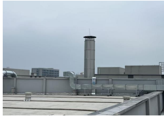
污水处理站废气收集及处理设备 (TA006)
