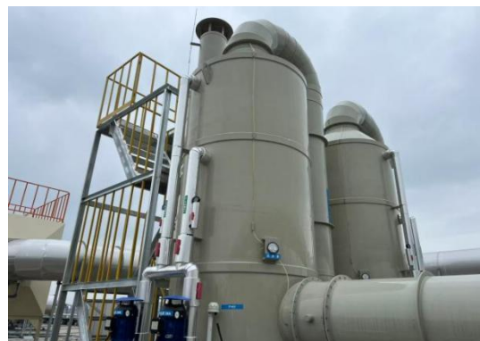
污水处理站废气收集及处理设备 (TA006)
