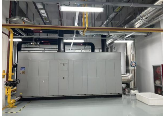
污水处理站废气收集及处理设备 (TA006)
