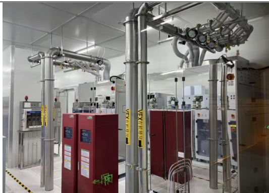
喷砂废气收集及处理设备 (TA004)
