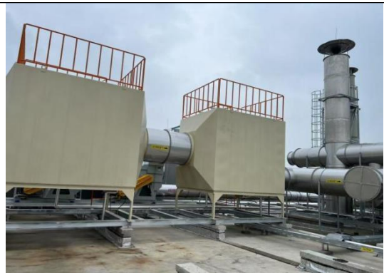
喷砂废气收集及处理设备 (TA004)
