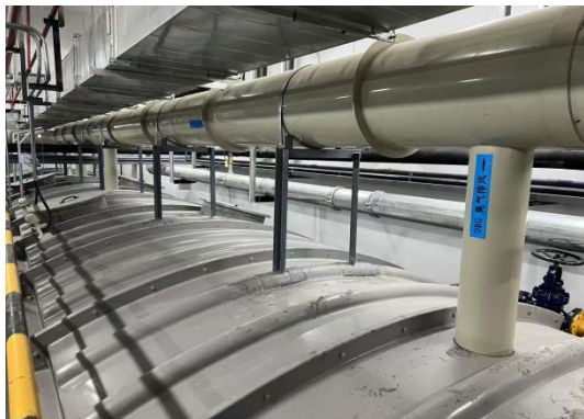
污水处理站废气收集及处理设备 (TA006)
