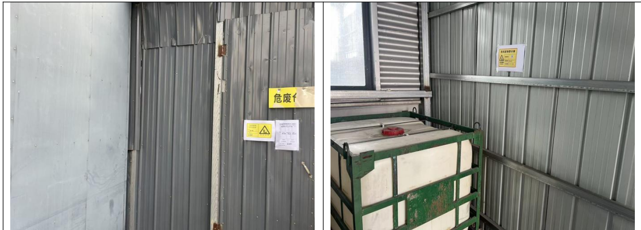
危废暂存点照片
