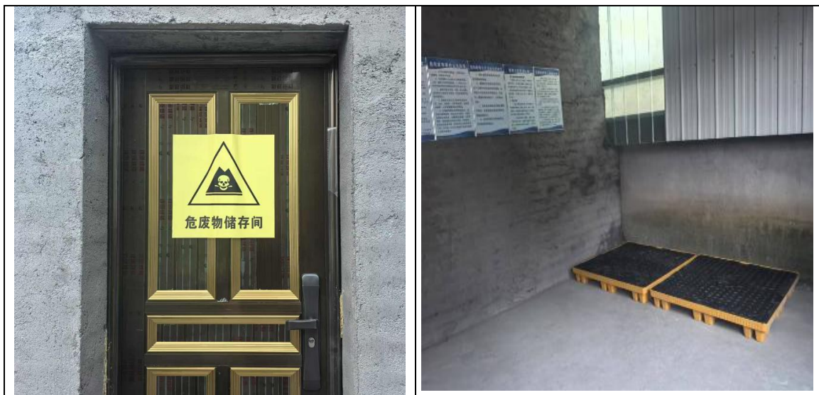
图 4.1.3-1 危废暂存库照片
