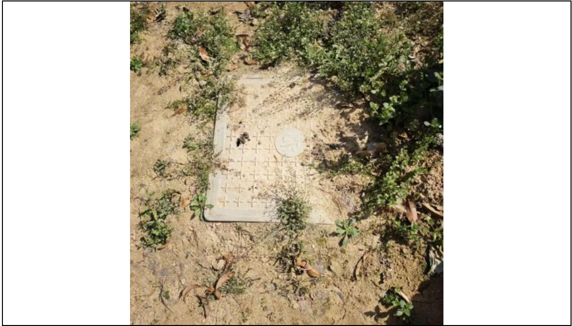
图 4.1.1-2 污水站（地埋）照片
