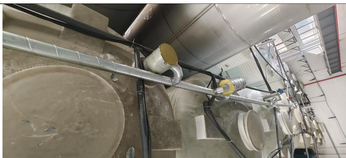
图 3-1 企业废气收集装置
