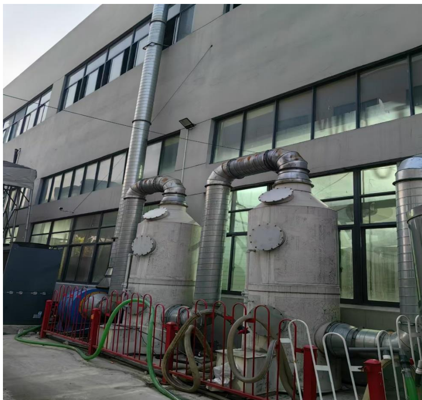
图 3-2 企业废气处理装置
